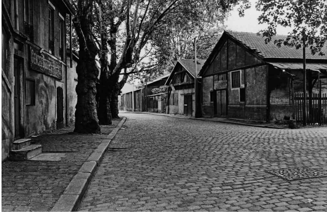
ENTREPÔTS DE BERCY
